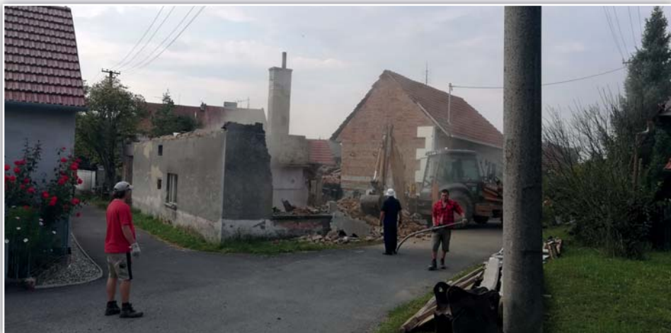
Rodinný dům „Ferdovo“ na Močidlech, který byl již nebezpečný pro své okolí, byl zbourán. O tom, co zde vznikne, dosud nebylo rozhodnuto.
